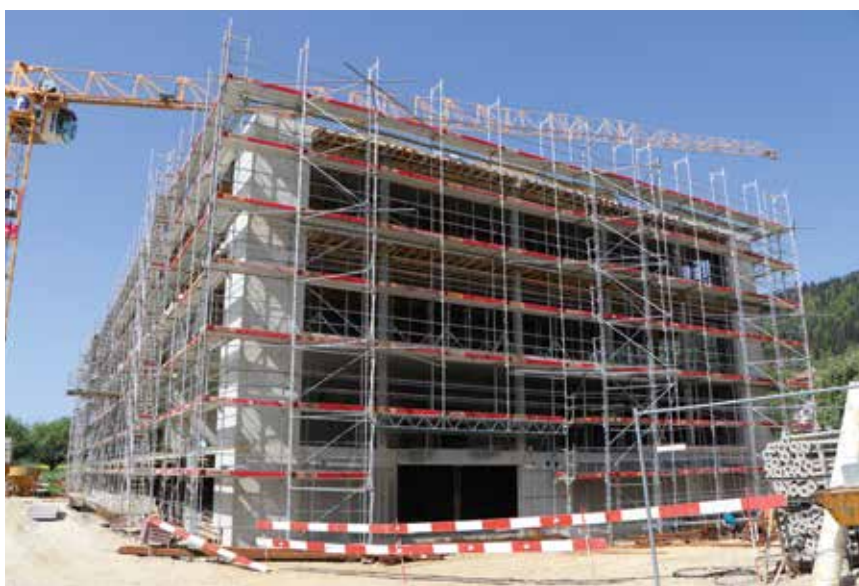
Le nouveau bâtiment d'Hifi Group en construction (photo pif).
